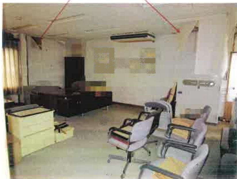
天井、内壁のクロスが剥がれ
