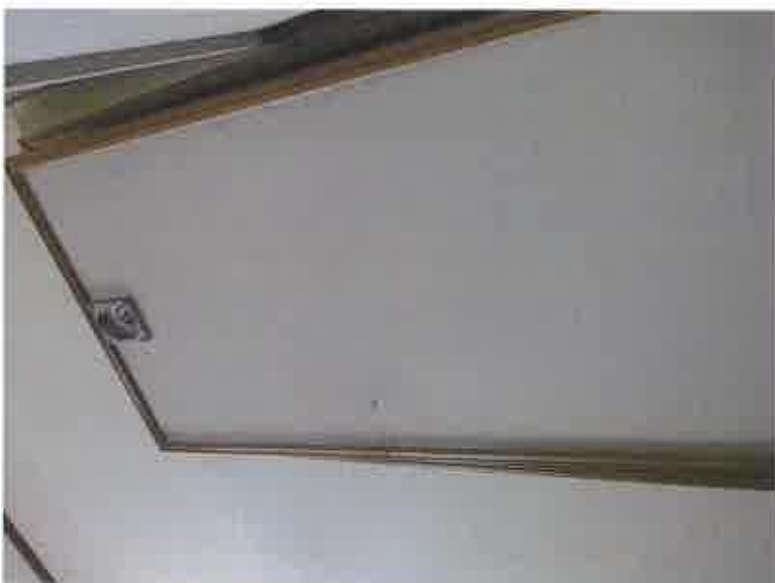
屋根裏収納入口
