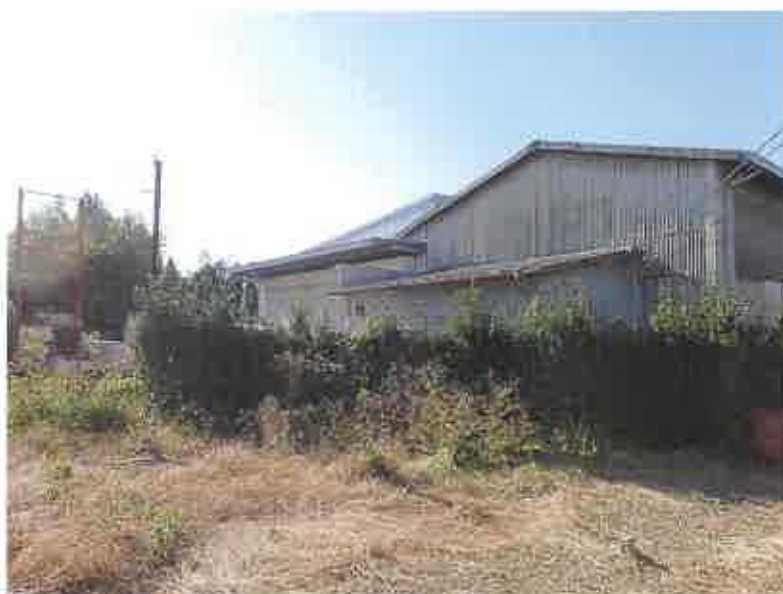
物件3の建物（工場・事務所）外観 ⑩
