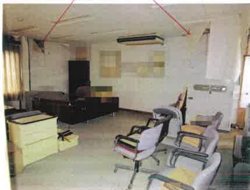
天井、内壁のクロスが剥がれ
