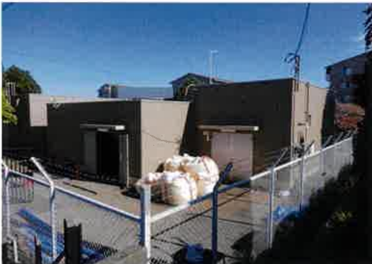
⑥ ポンプ室
