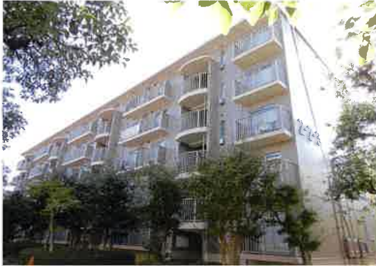
① 一棟の建物の外観
