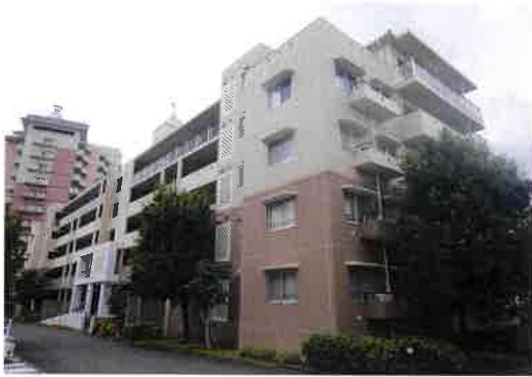
① 一棟の建物の外観
