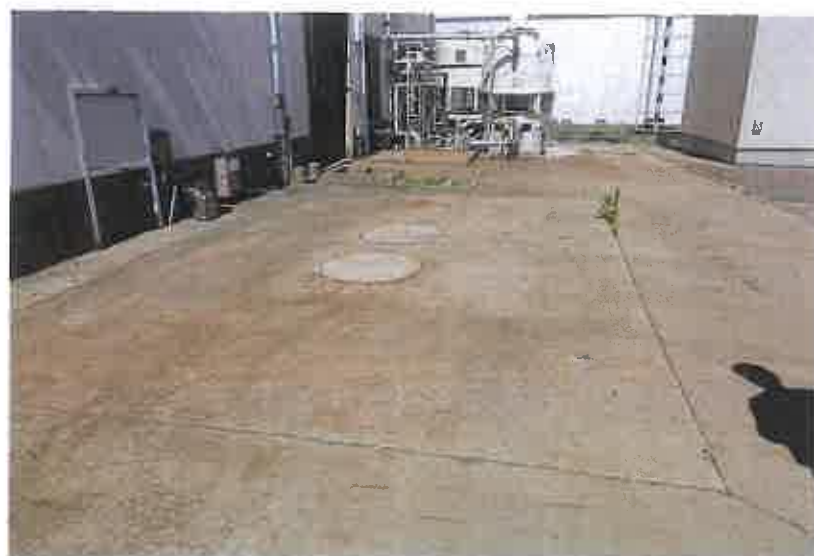
重油タンクが設置されていた辺り
