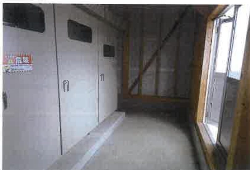
未登記附属建物の内部
