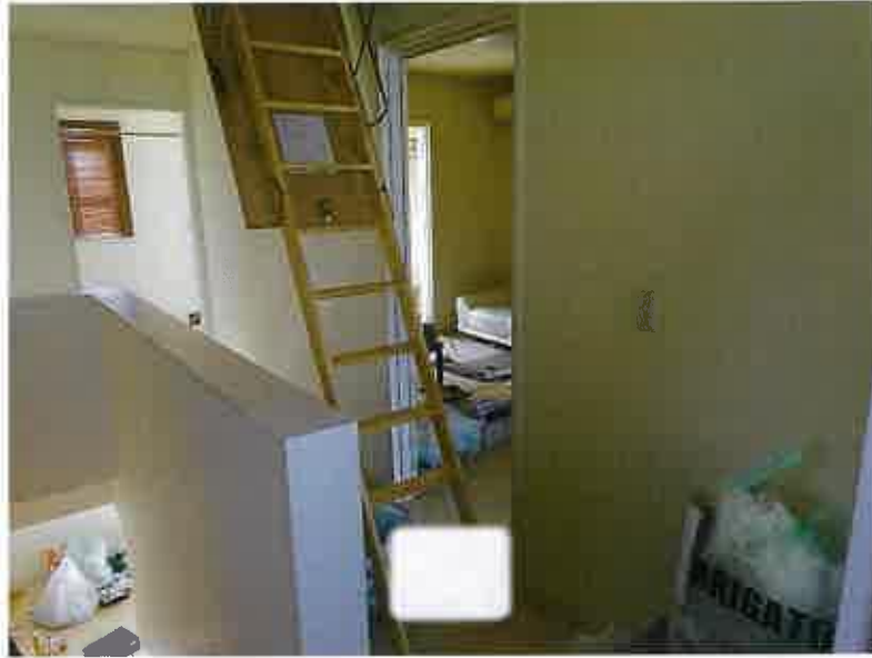
2階（廊下（梯子ユニット））⑦
