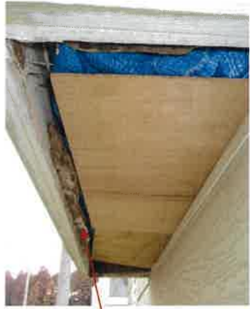
出窓下のシロアリ被害の跡(推測)
