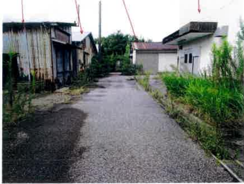
物件27主である建物
