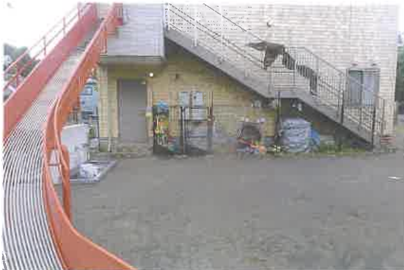
避難用すべり台
