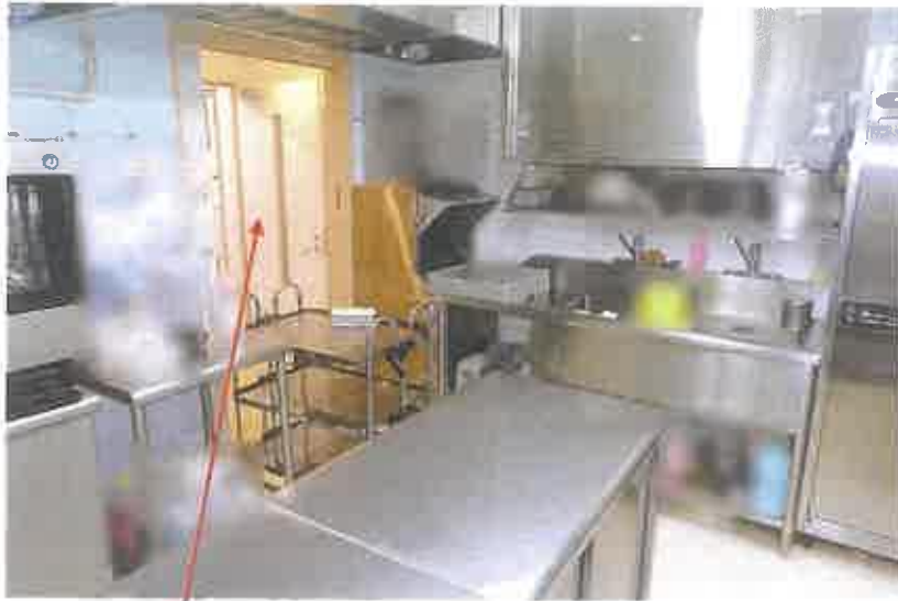
目的外建物へ通じるドア 1階調理室
