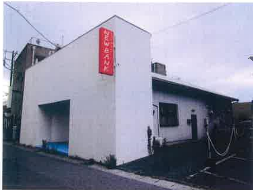
北側隣地2542番9上の建物に付設される物置等の越境部分 物件1 2
