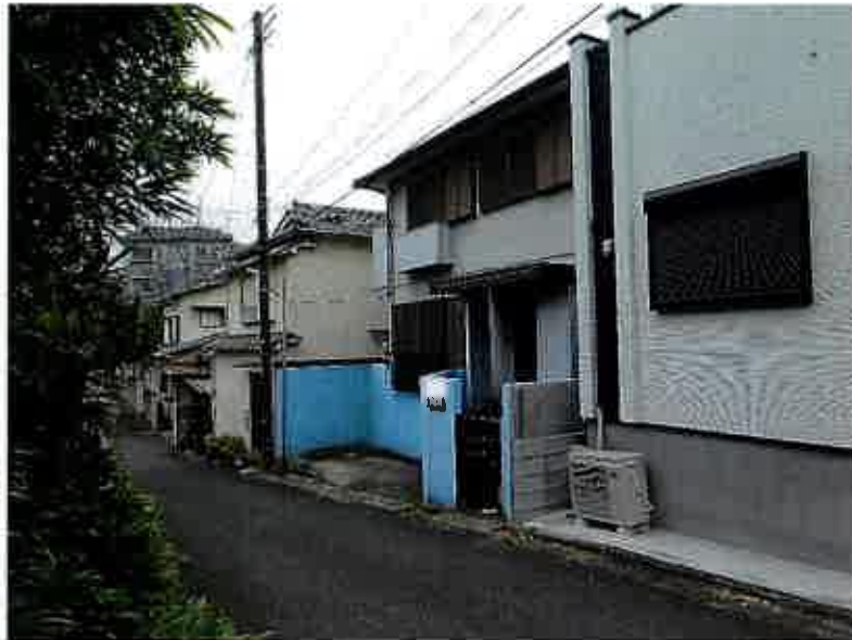
物件3の建物（物件1の土地）
