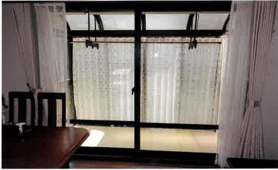
4 (物件2 1階サンルーム(増築部分))
