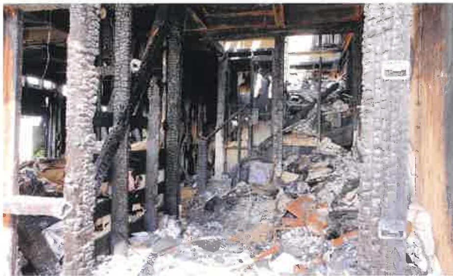
4 (物件2 東側(1階玄関付近))
