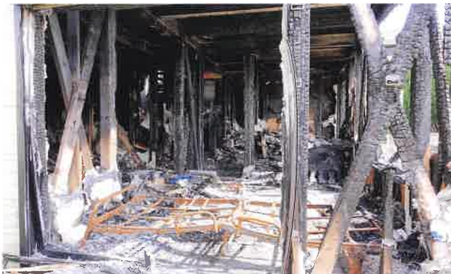
5 (物件2 東南側(1階和室付近))
