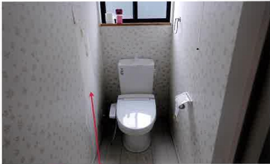
11 (物件6 1階トイレ)
