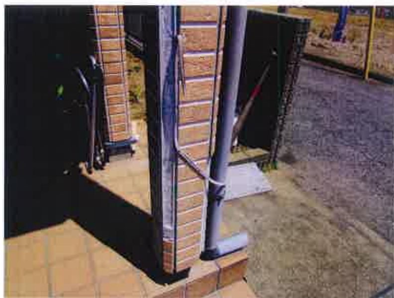
外壁材の破損
