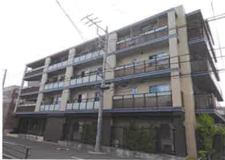
① 一棟の建物の外観
