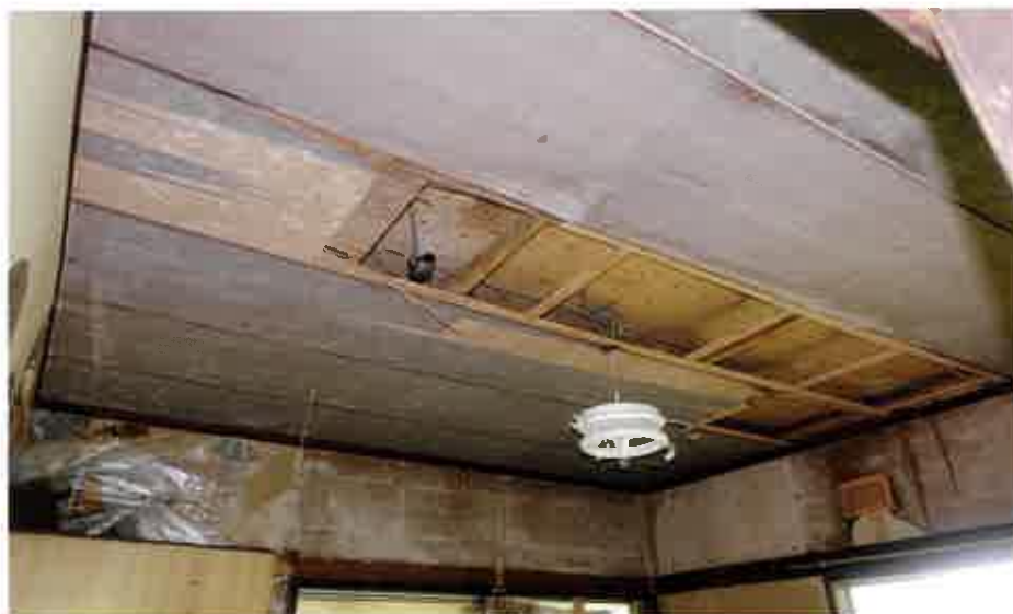
15 (物件 4 1階和室(1)の天井)
