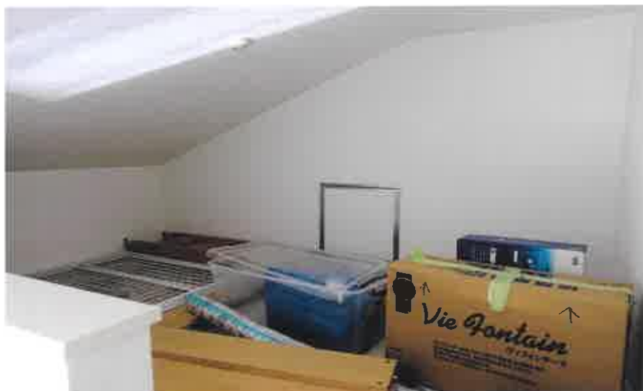
6 (物件2 2階ロフト)
