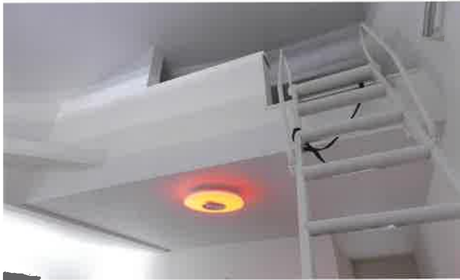
5 (物件2 2階ロフト出入口)
