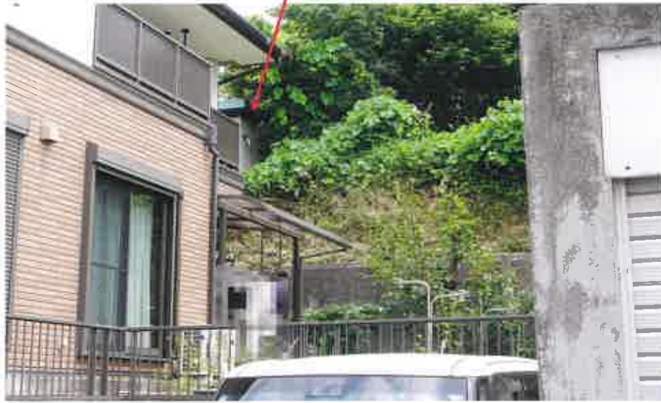
物件7附属建物符号1(作業所)
