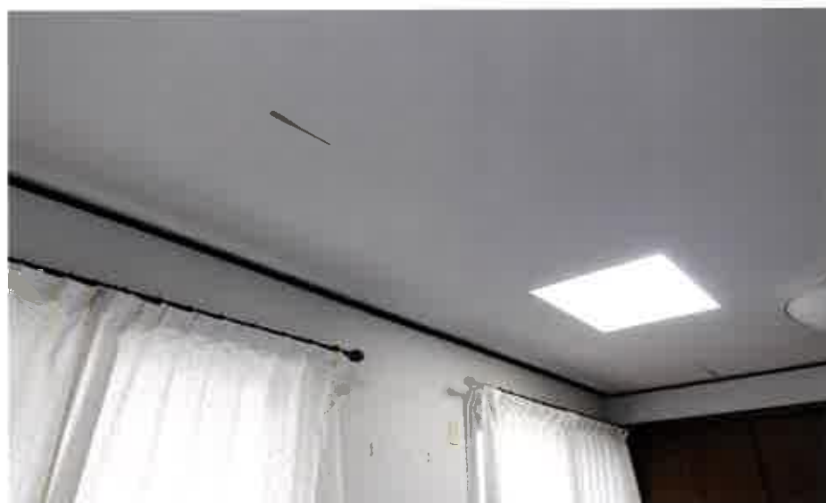
6 (物件2 2階洋室の天井)
