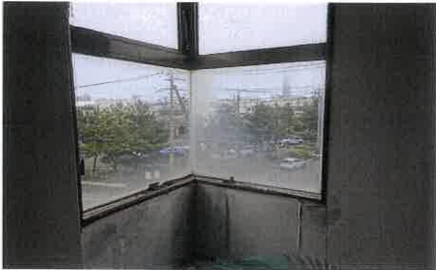
窓枠の腐食
