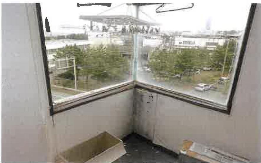
窓枠の腐食
