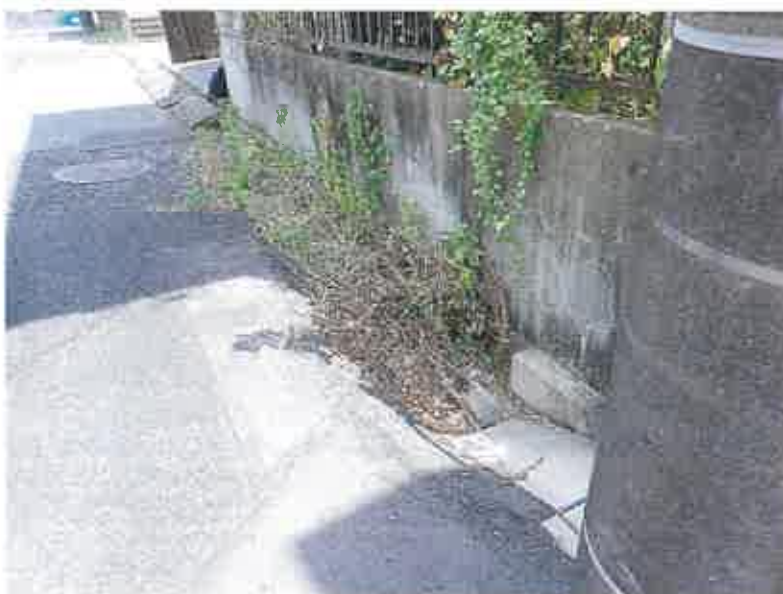
接面道路の一部の陥没 ⑥
