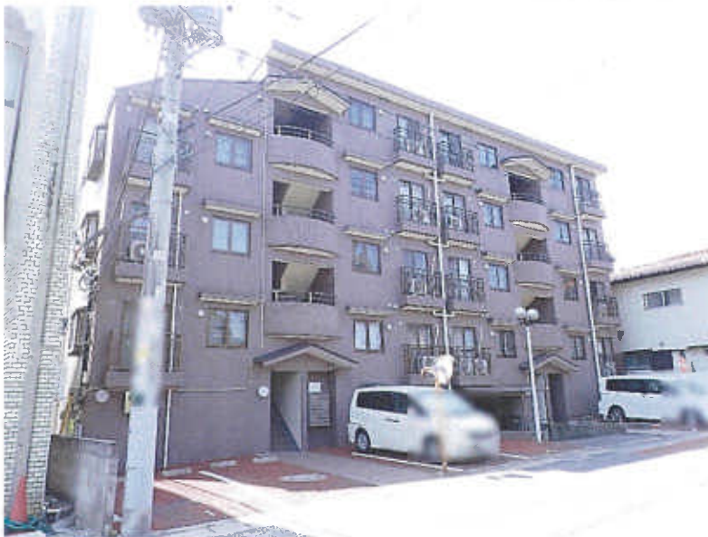
本建物を含む一棟の建物 ①
