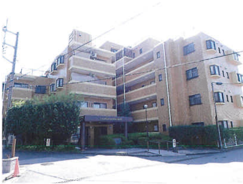
本建物を含む一棟の建物（北西側から）①
