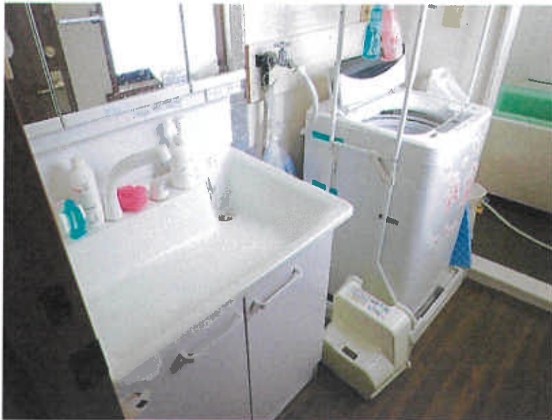
2、3階居宅（浴室）⑧
