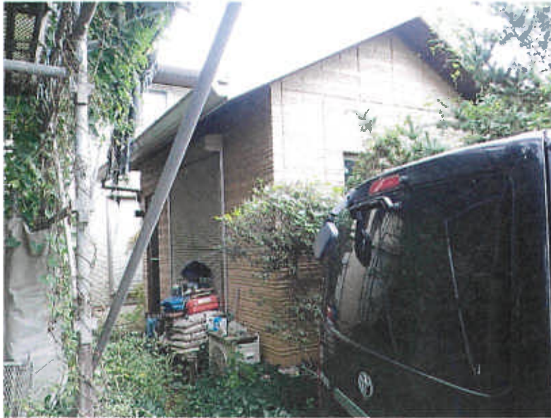
足場で組まれた構造物 ⑧
