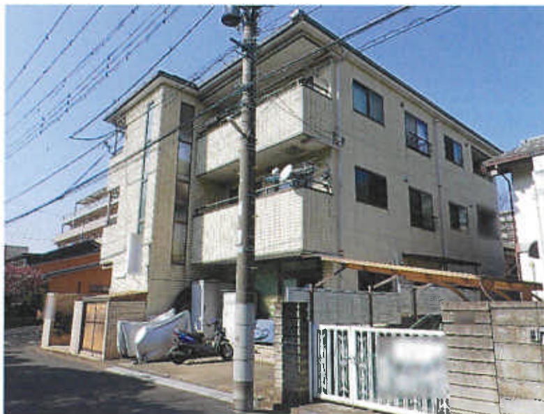
事務所部分（事務所）②
