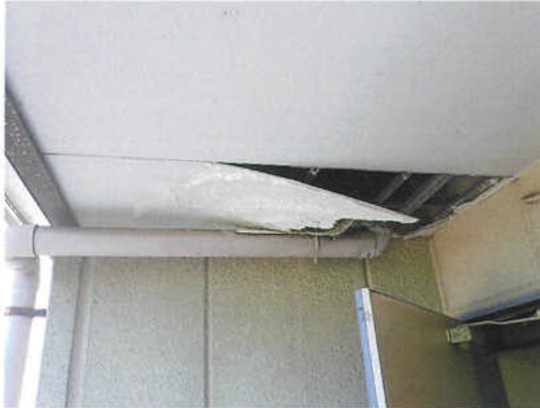
ゴミ置場（未登記附属建物） ③②
