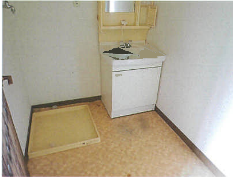
201号室（浴室）⑪
