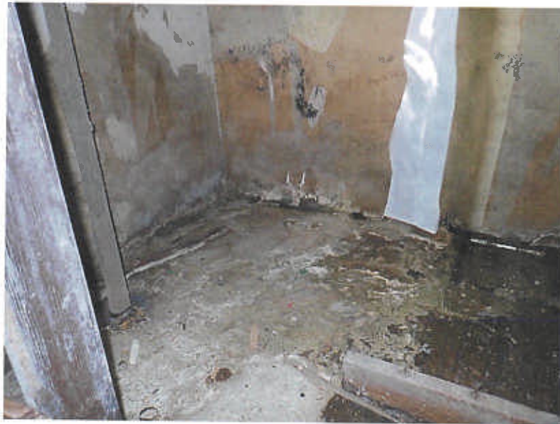
103号室 (床材・壁材の腐食) ⑮
