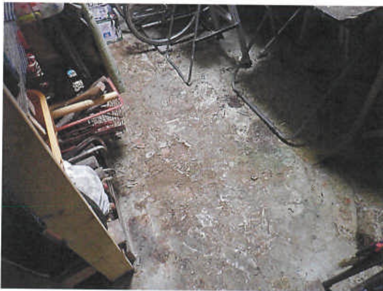
103号室 (床材・壁材の腐食) ⑮
