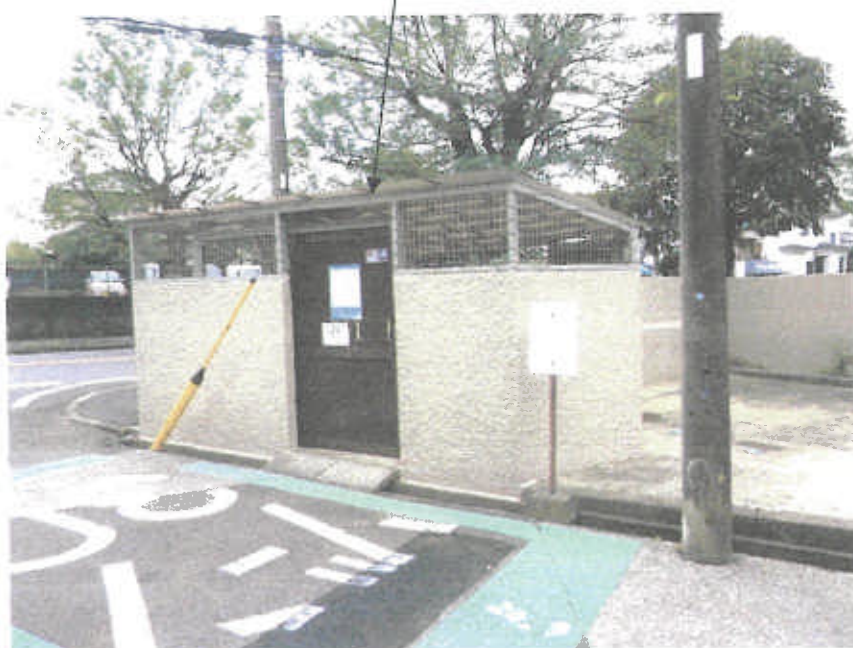
未登記附属建物2（ゴミ置場）
