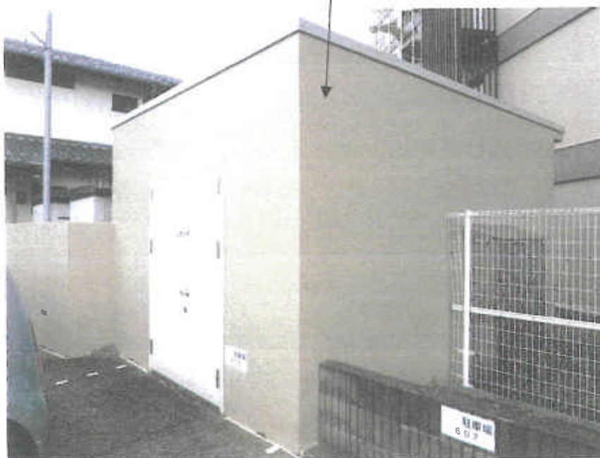
未登記附属建物1（電気室）
