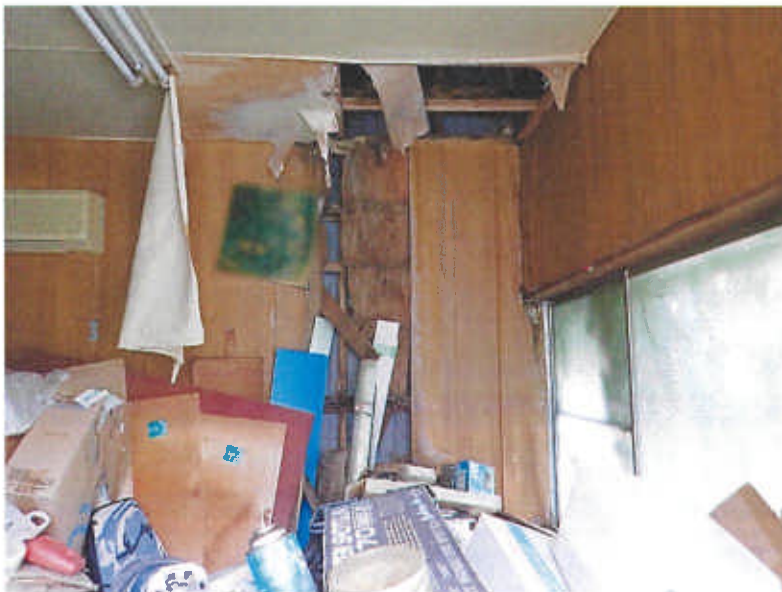
物件3の建物（天井・壁の破れ）⑥
