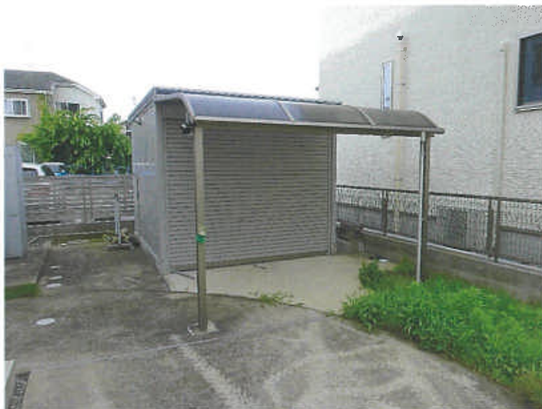
物件2の建物（主である建物 1階 洋室（東側））⑤
