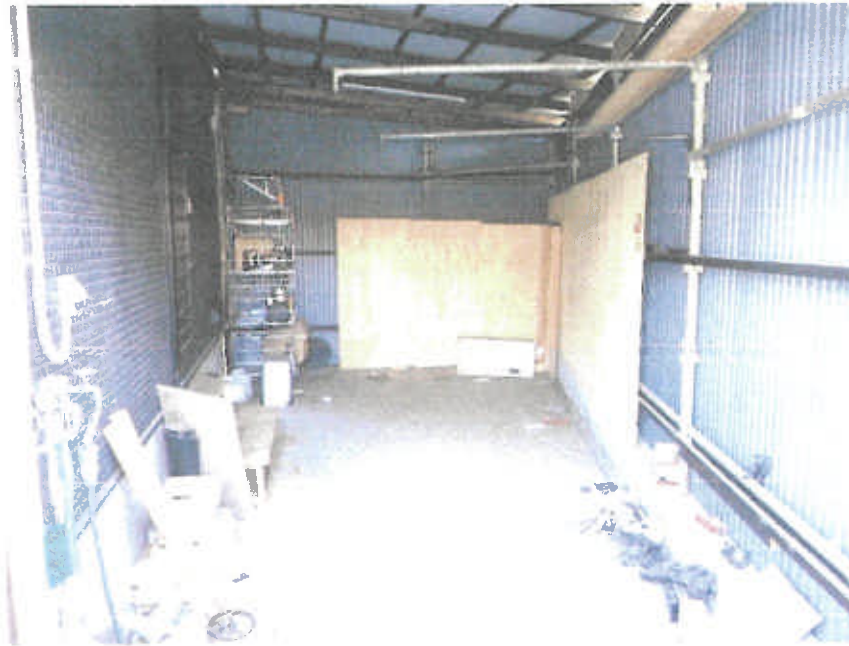
下屋の内部の状況
