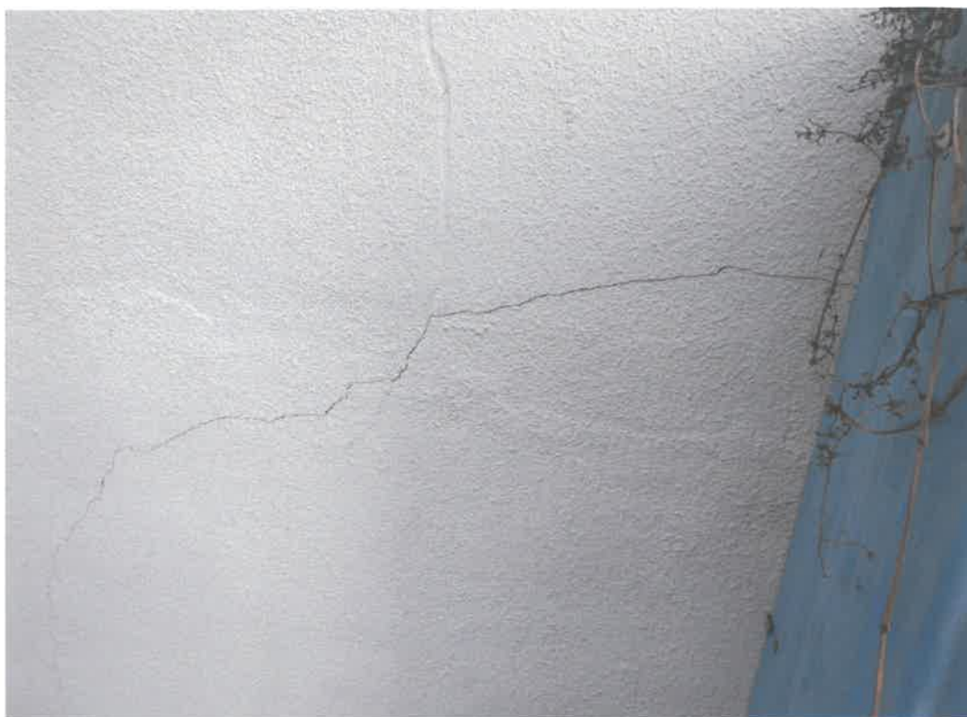
外壁の亀裂 (物件2 附属建物)
