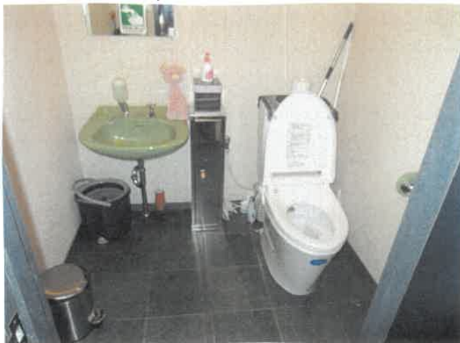
物件25 東側店舗トイレの状況 ⑩
