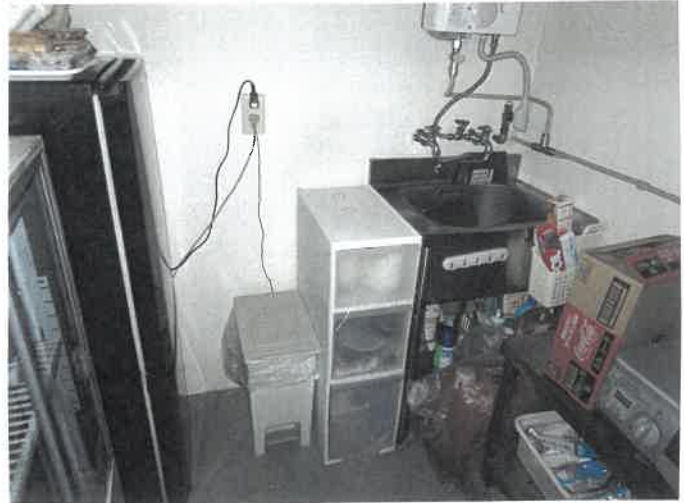
物件25 西側店舗厨房の状況 ⑤
