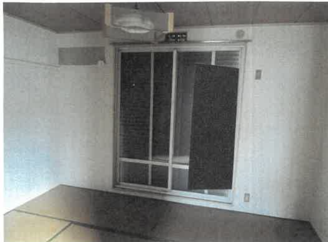
物件17 2階 202号室 和室の状況 ⑱
