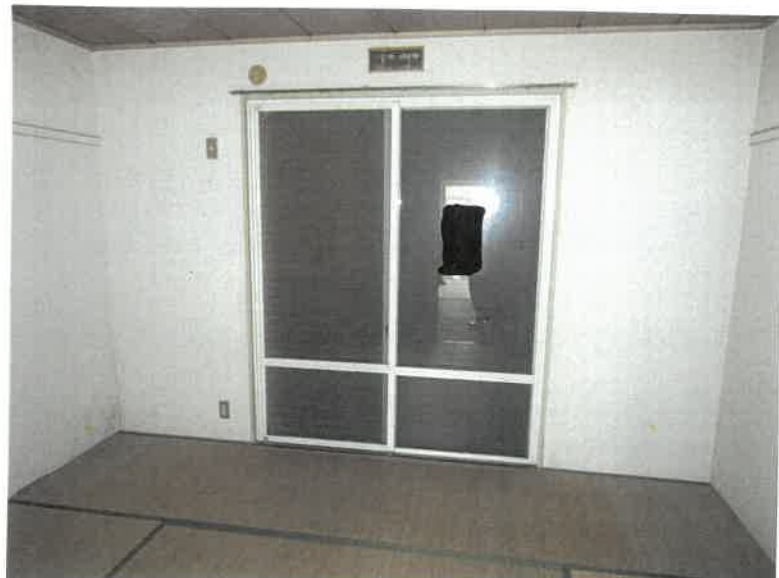
物件17 1階 101号室 和室の状況
