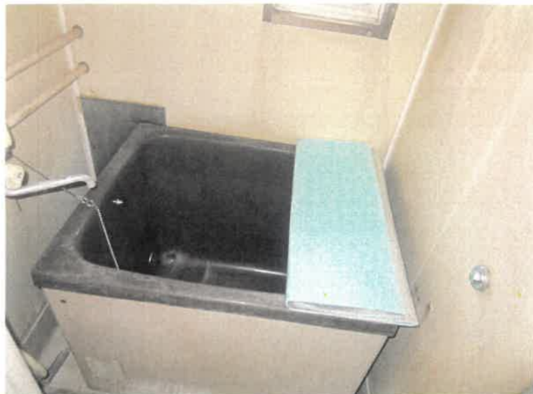
物件17 1階 102号室 浴室の状況
