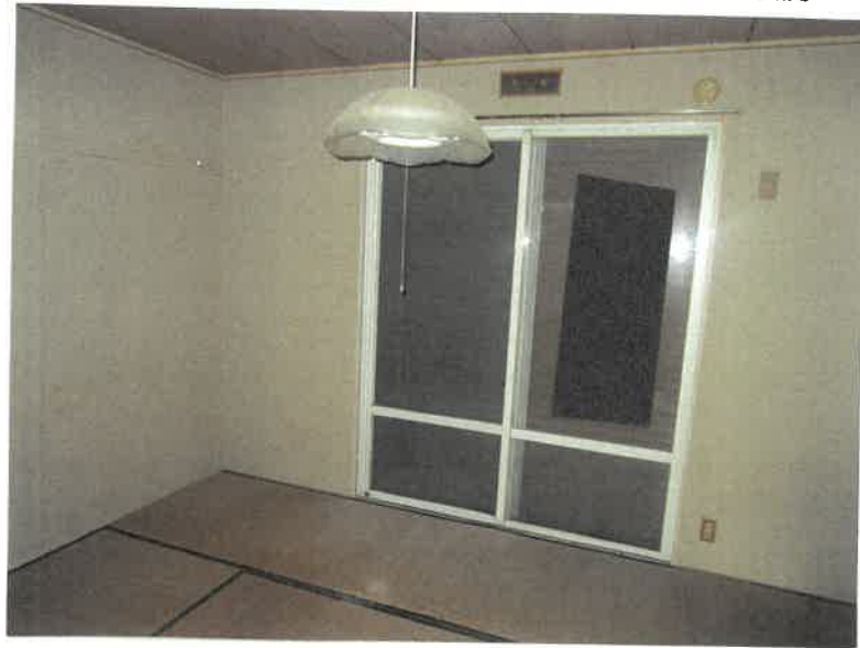
物件17 1階 102号室 和室の状況
