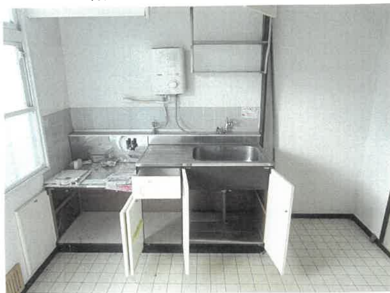
物件17 1階 101号室 キッチンの状況
