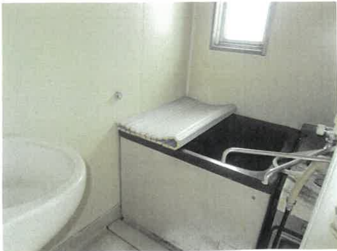
物件17 2階 201号室 浴室 ⑯ の状況
