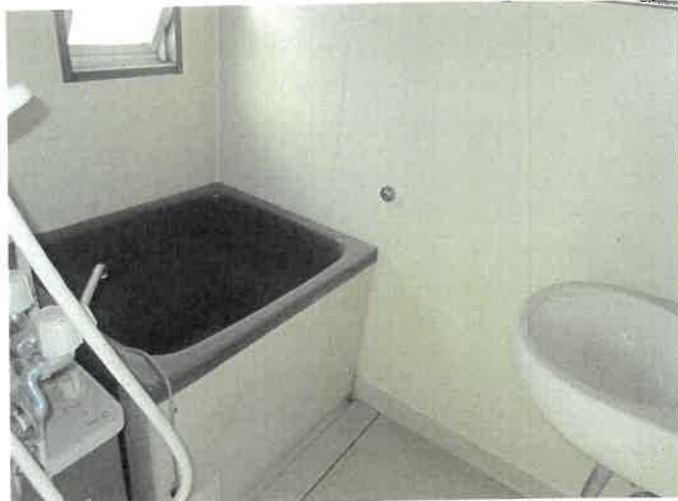
物件17 2階 202号室 浴室の状況 ㉓
