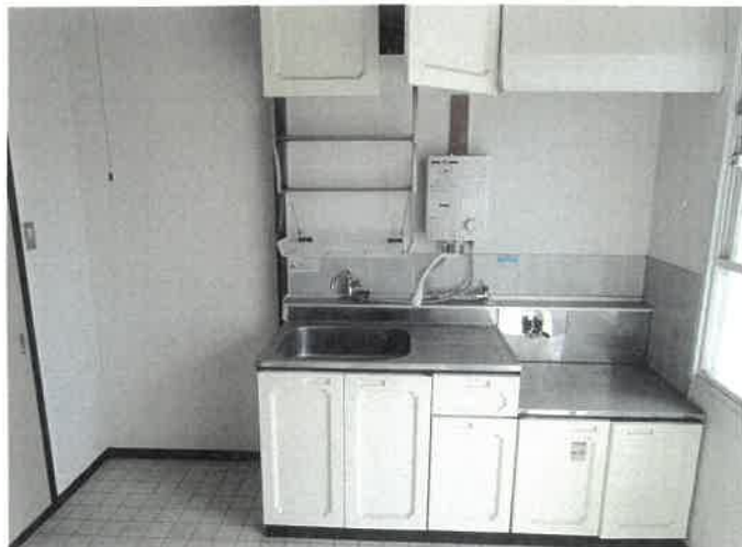
物件17 2階 202号室 キッチンの状況 ㉒
