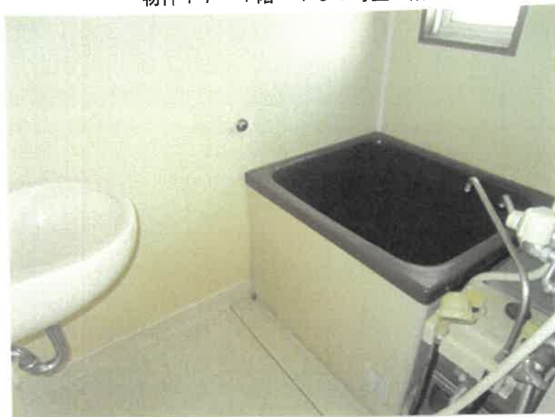
物件17 1階 101号室 浴室の状況
