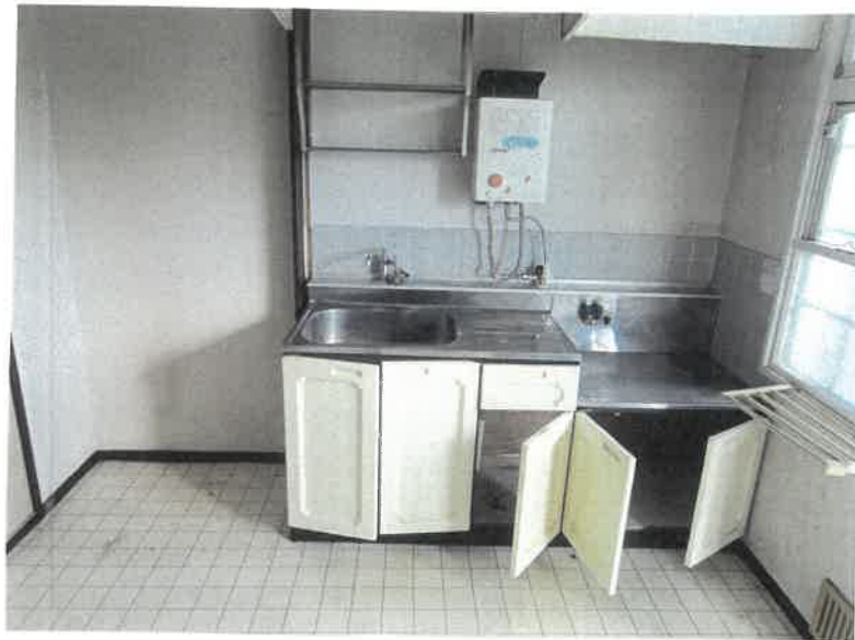
物件17 1階 102号室 キッチンの状況
