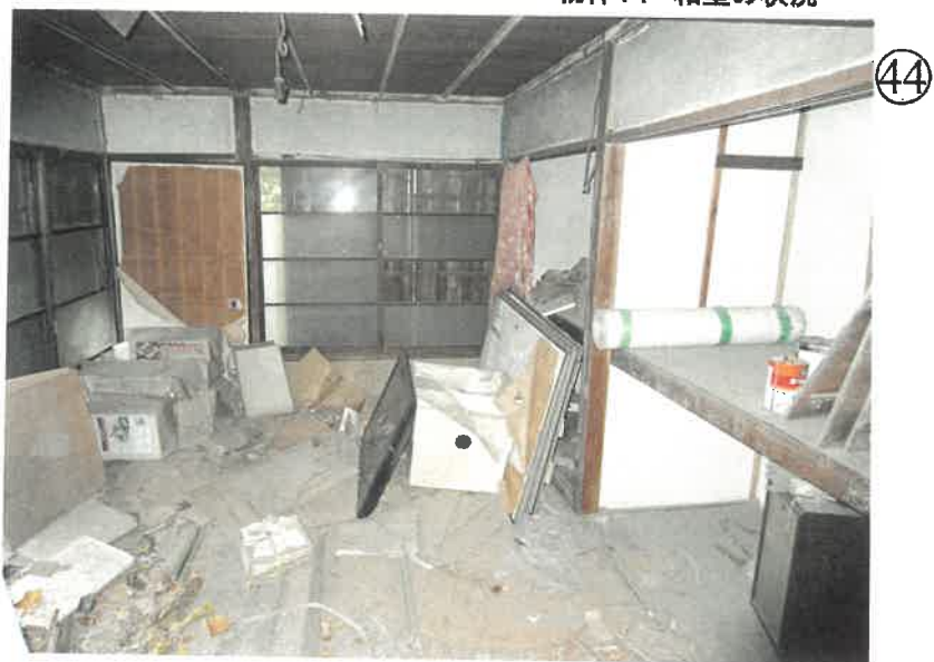
物件11 和室の状況
