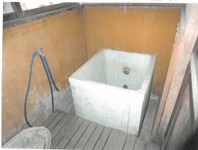
物件4 浴室の状況
