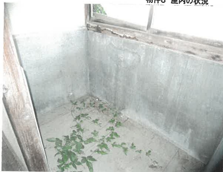
物件8 屋内の状況
