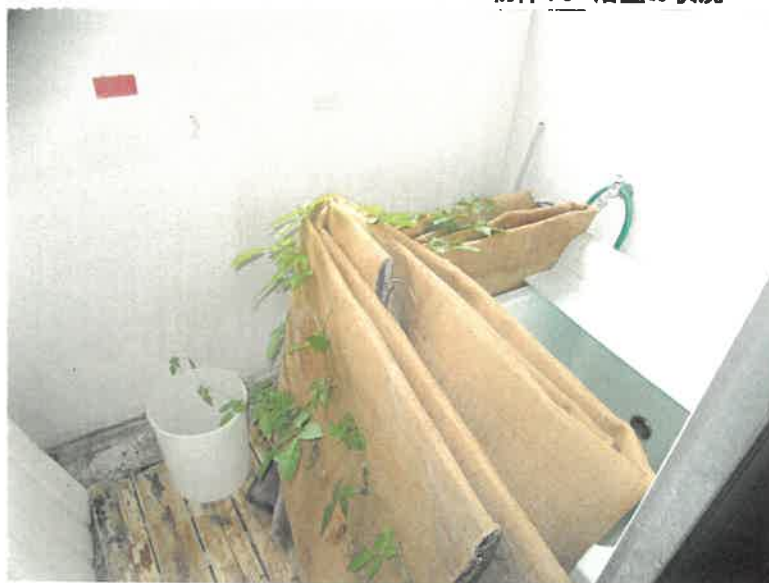
物件10 浴室の状況
