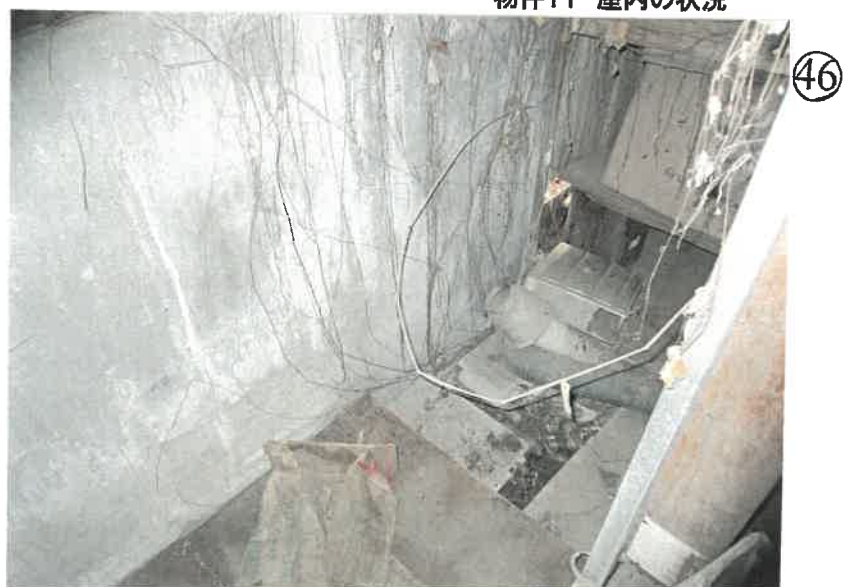
物件11 屋内の状況
