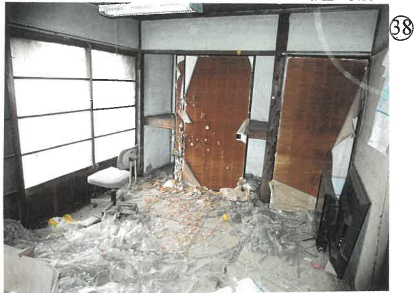
物件5 和室の状況
