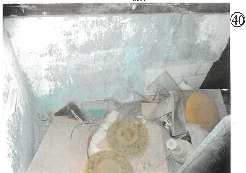
物件5 屋内の状況
