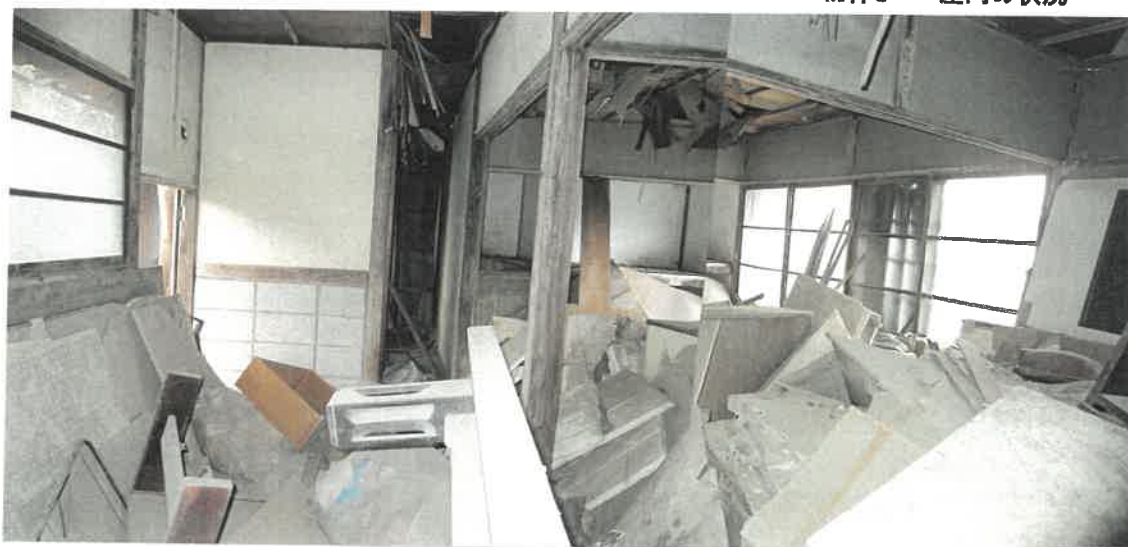
物件9 屋内の状況
