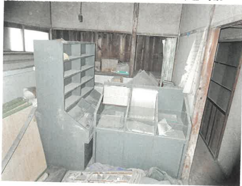
物件4 和室の状況
