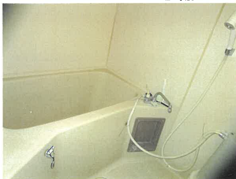
物件15 2階 205号室 浴室の状況
