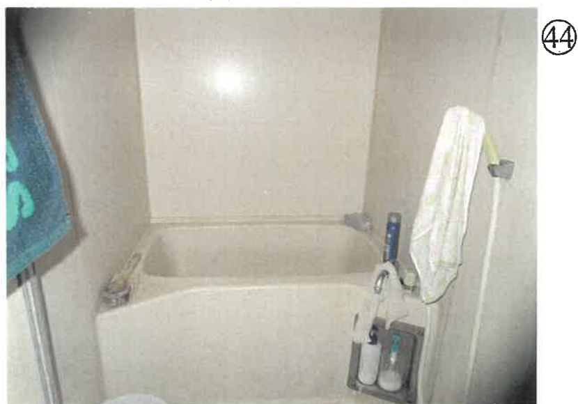
物件15 3階 305号室 浴室の状況
