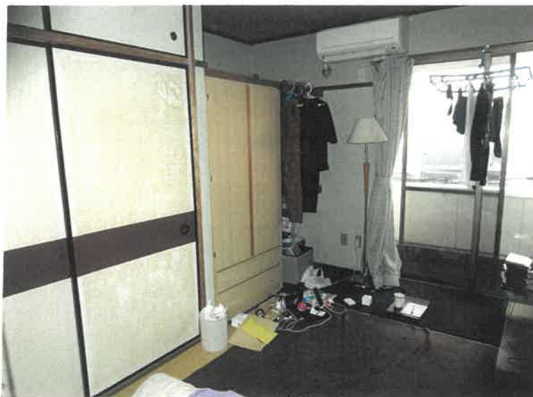
物件15 4階 403号室 和室の状況
