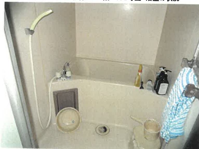
物件15 4階 403号室 浴室の状況
