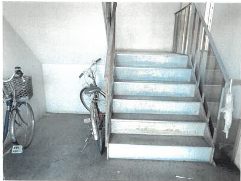
物件15 1階 階段部分の状況
