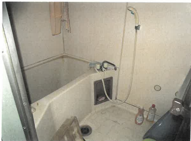
物件15 2階 202号室 浴室の状況
