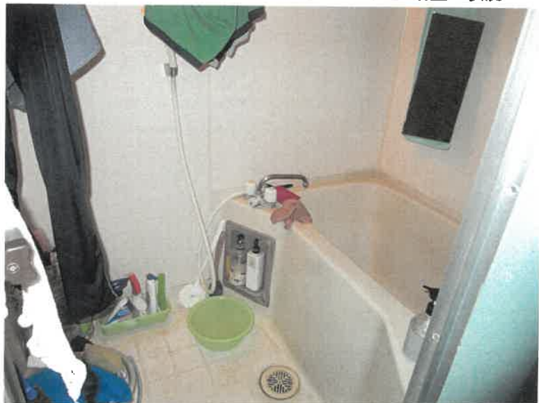
物件15 2階 203号室 浴室の状況
