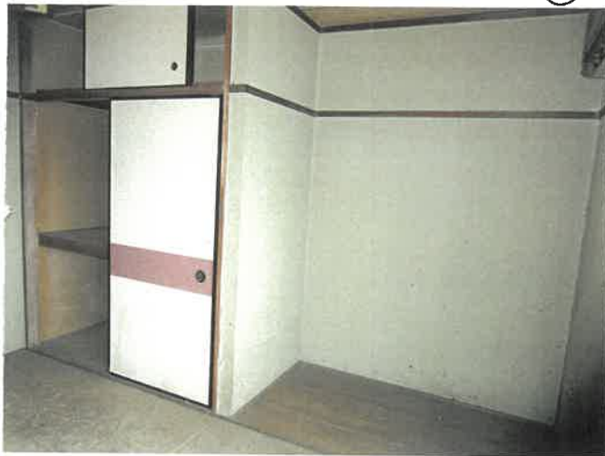
物件15 4階 406号室 和室の状況 ⑥5
