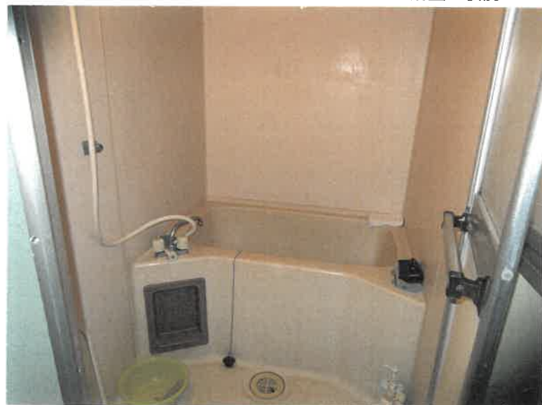
物件15 3階 303号室 浴室の状況
