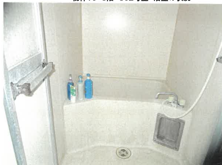
物件15 3階 302号室 浴室の状況
