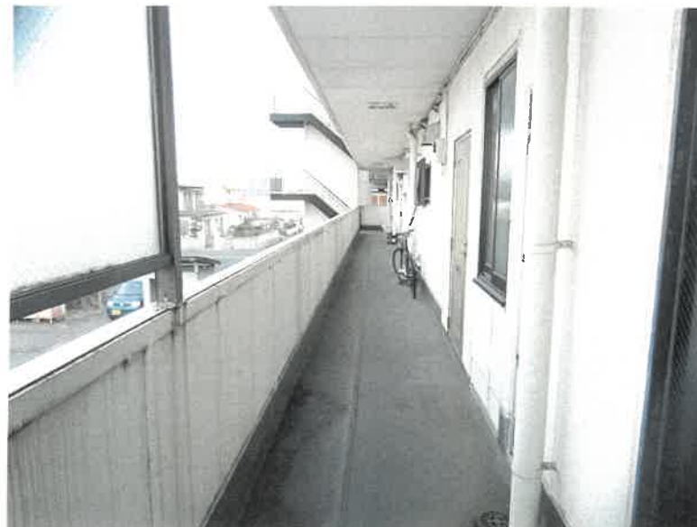
物件15 2階 外廊下の状況
