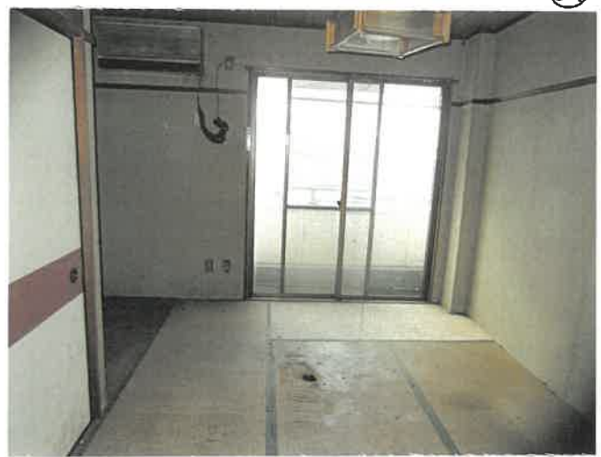
物件15 4階 406号室 和室の状況 ⑥4
