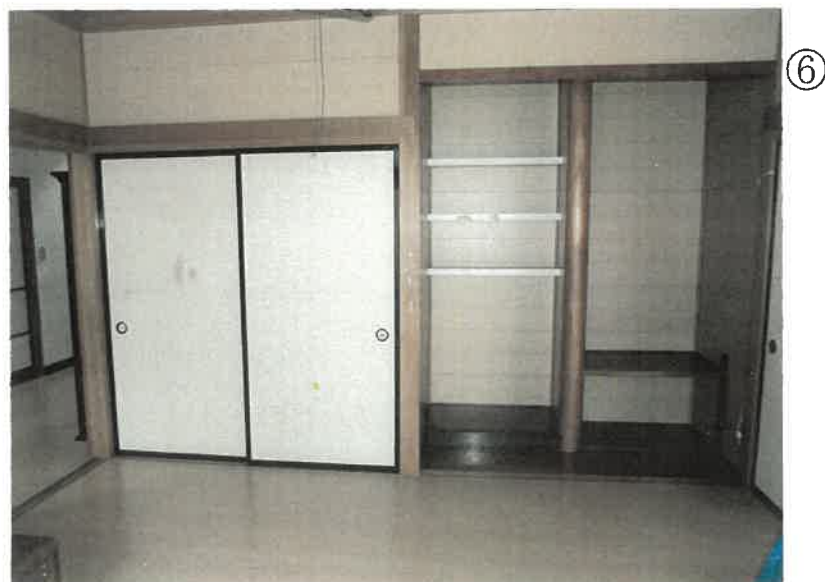
物件3 1階 洋室の状況
