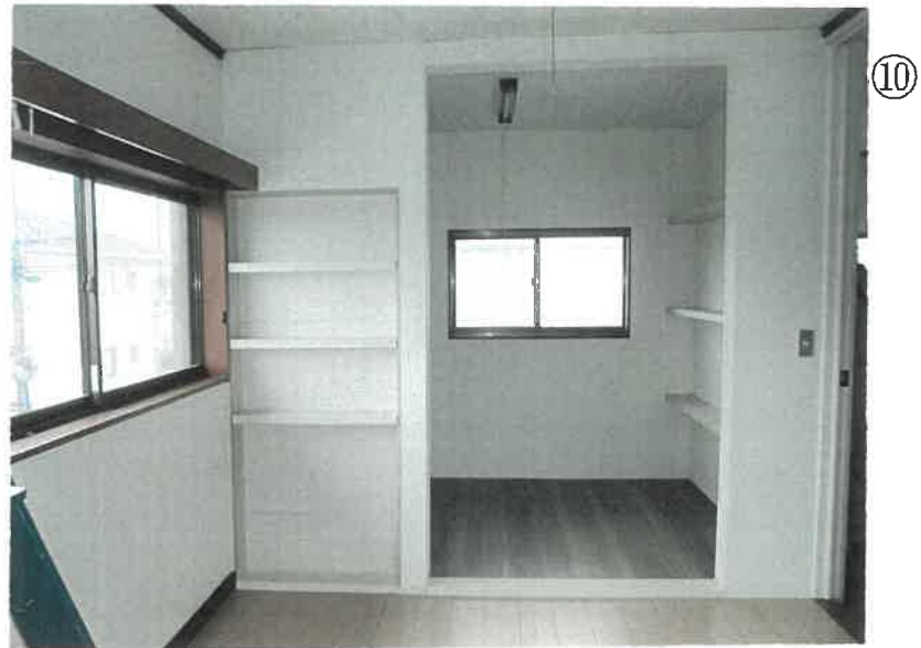
物件3 2階 洋室の状況
