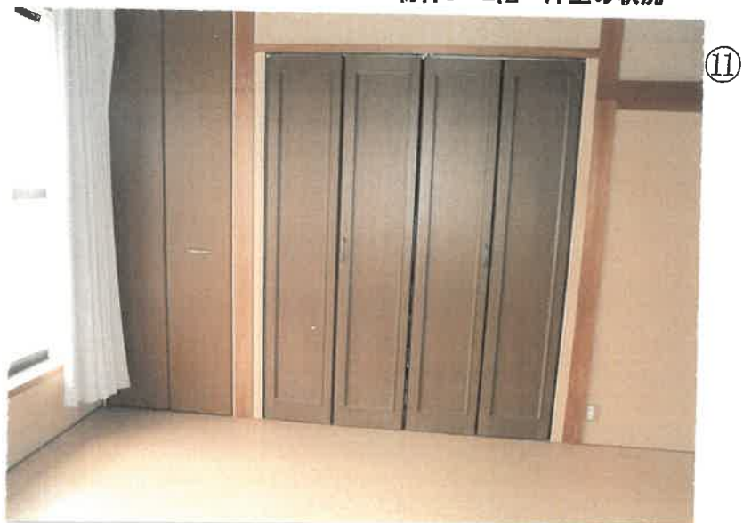
物件3 2階 洋室の状況
