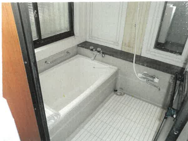
物件3 1階 浴室の状況
