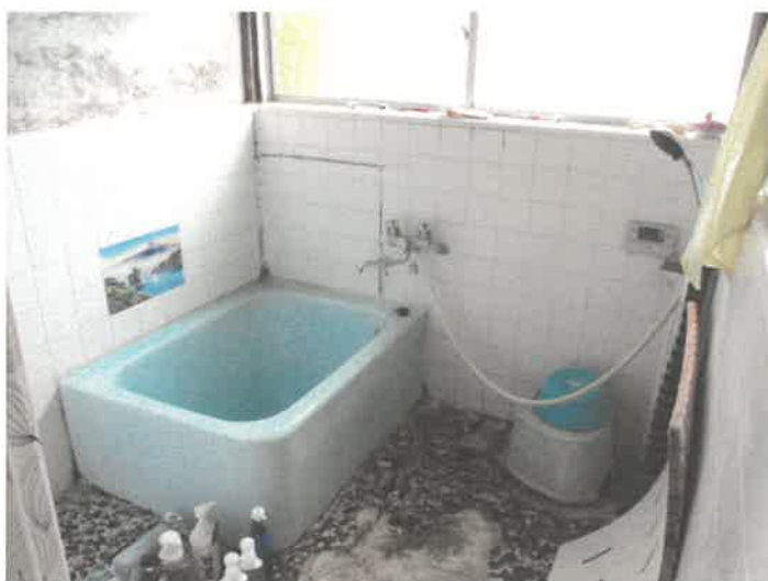
写 真 1 3 (物件 3 建物浴室)
