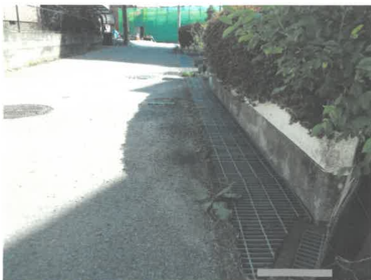
写真3（東側接面道路）
