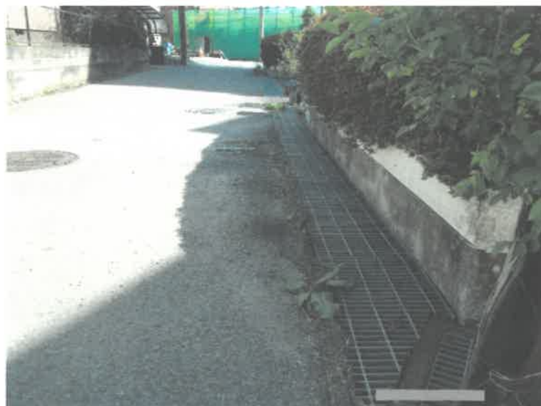
写真3（東側接面道路）
