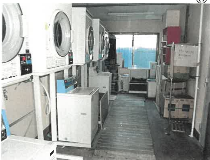
1階 コインランドリー室の状況 ⑪
