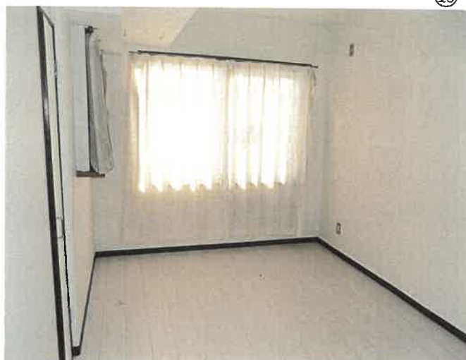
1階 100号室 洋室の状況 ⑬
