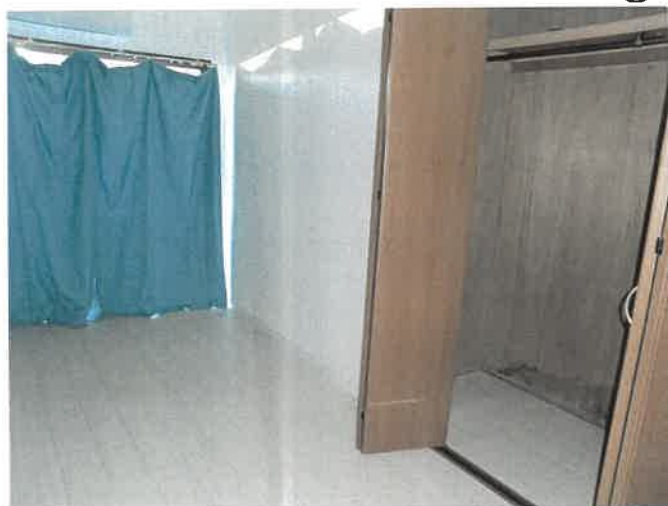
1階 106号室 洋室の状況 ②8
