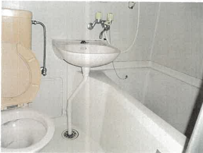
2階 222号室 浴室の状況 ⑧①
