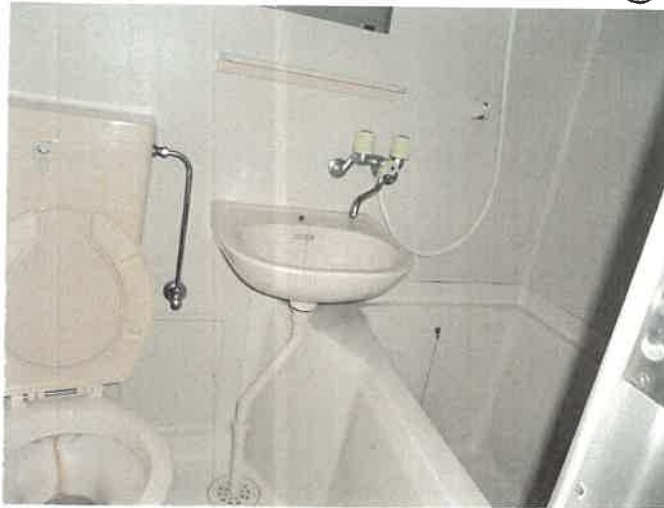
2階 218号室 浴室の状況 ⑦②
