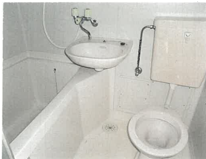
1階 102号室 浴室の状況 ②3
