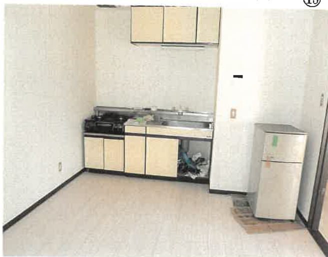
1階 100号室 リビング・ダイニング・キッチン の状況 ⑮
