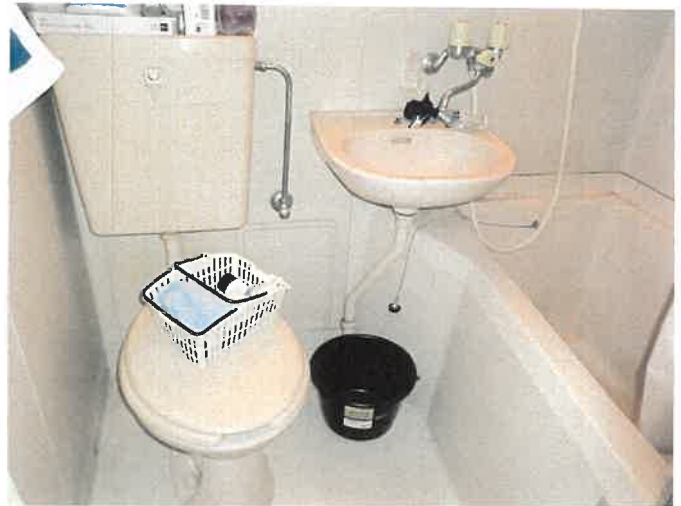
1階 101号室 浴室㉑
