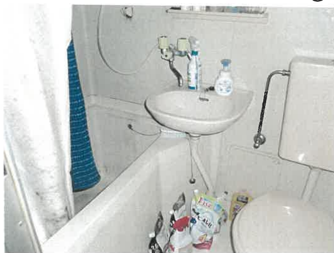
1階 105号室 浴室の状況 ②7
