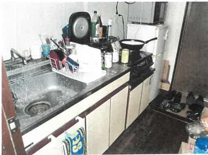
2階 205号室 キッチンの状況 (50)
