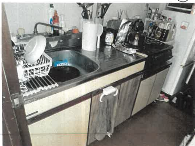
1階 105号室 キッチンの状況 ②6
