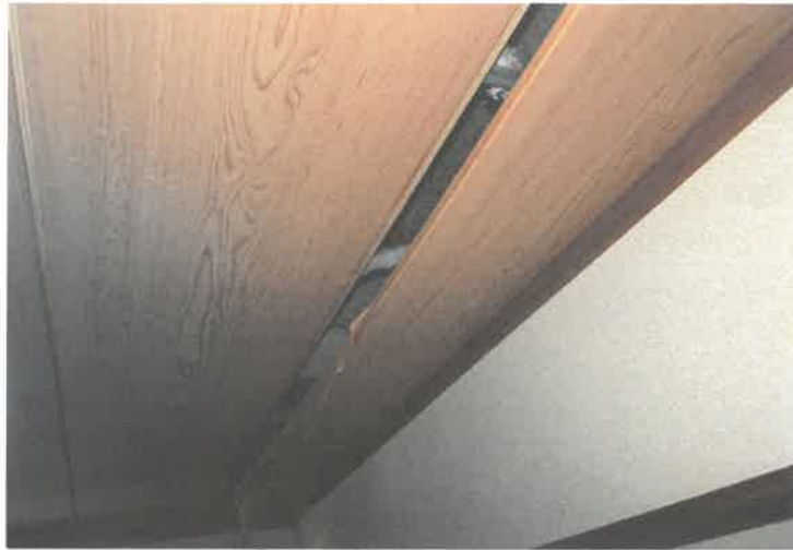
201号室 東側和室天井の状況
