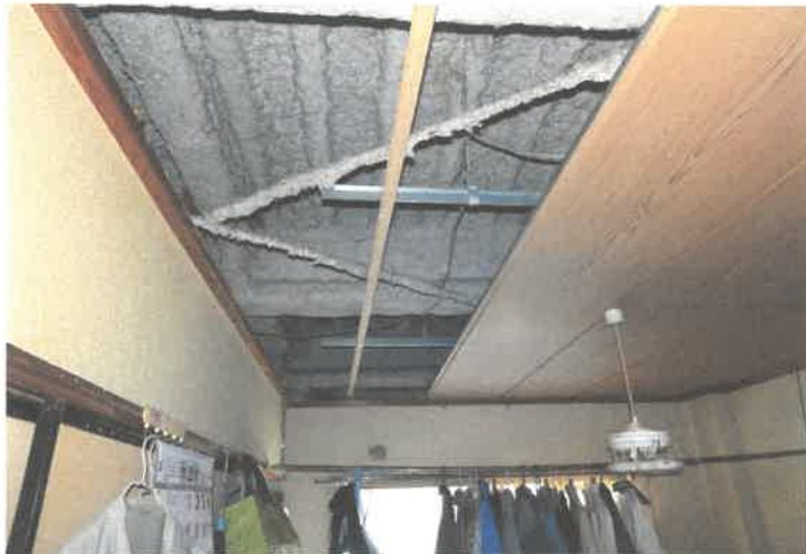
203号室 西側和室の天井の状況
