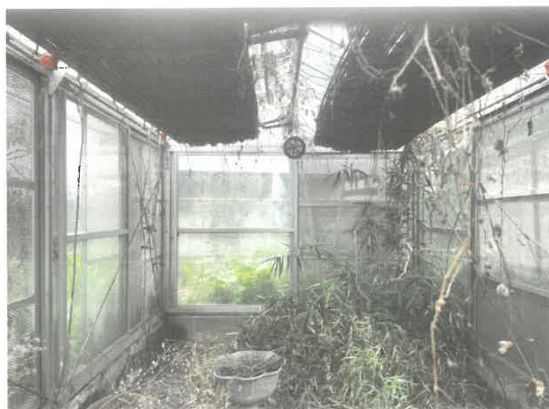
21 未登記附属 建物3内部
