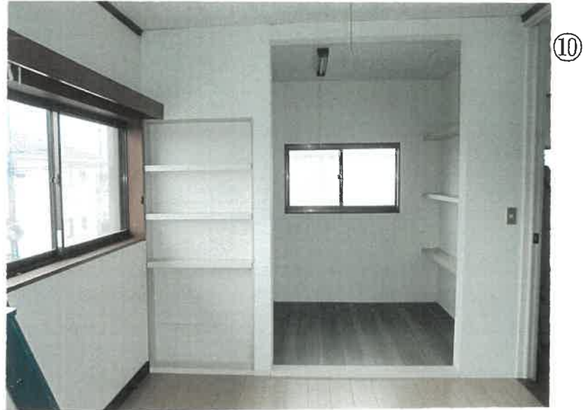
物件3 2階 洋室の状況
