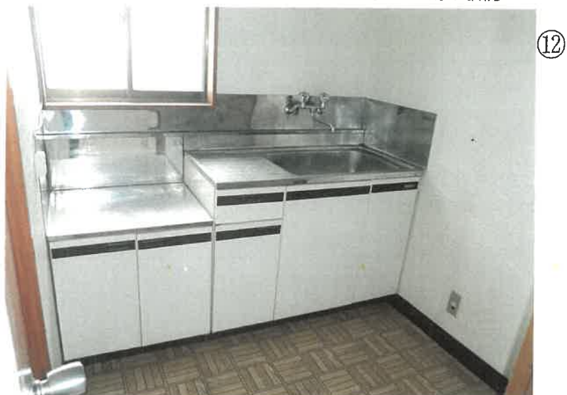
物件3 2階 台所の状況
