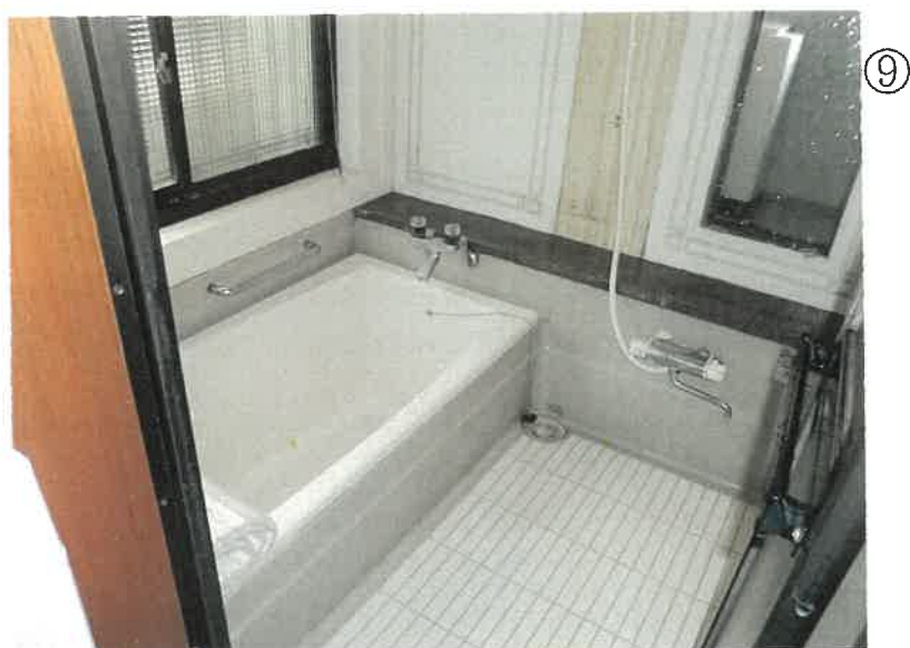
物件3 1階 浴室の状況
