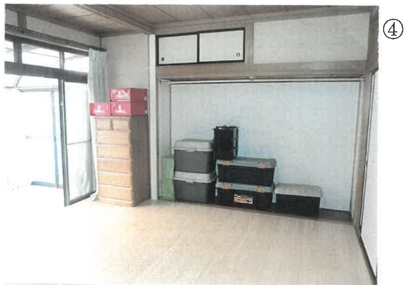
物件3 1階 洋室の状況
