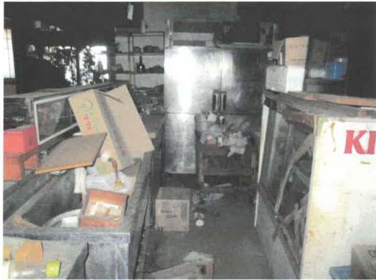
写真5 (厨房 (未登記増築部分))
