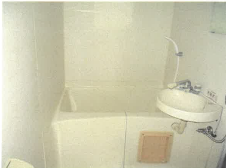
写真28 (702号室ユニットバス)
