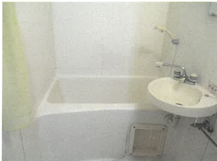
写真7 (305号室ユニットバス)
