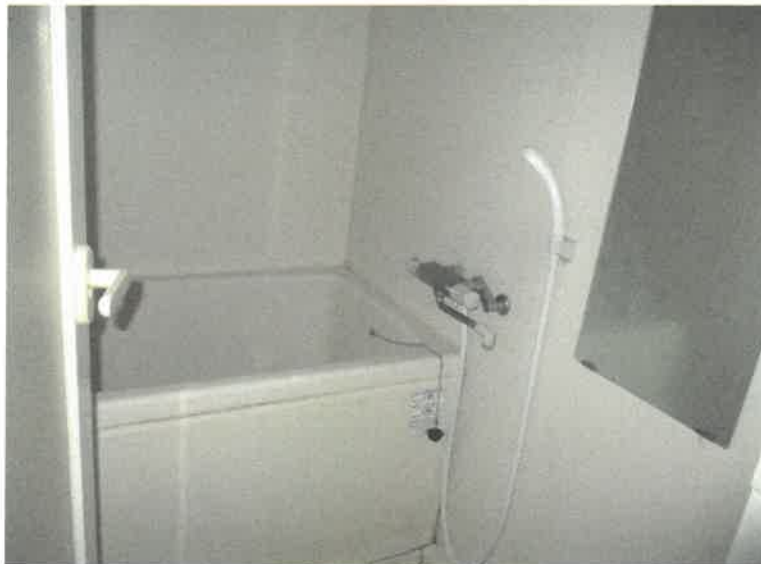
写真16 (502号室ユニットバス)
