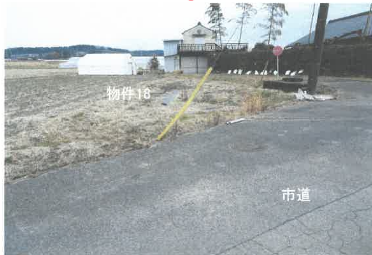
外観(防火水槽)
